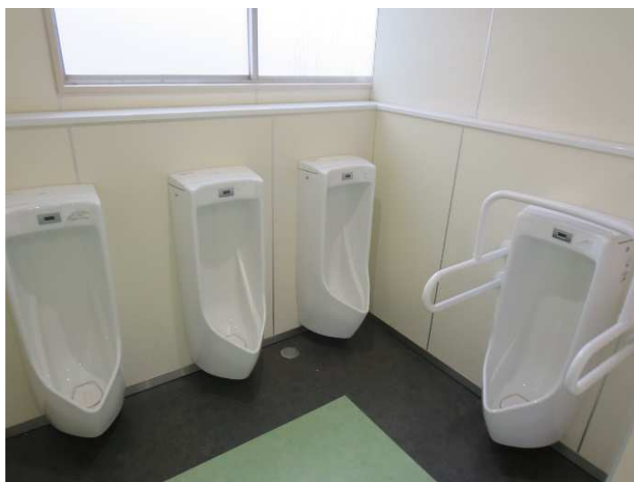
トイレ改修後
